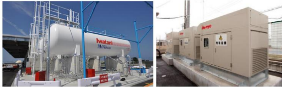
LPガスタンク基礎の耐震補強
