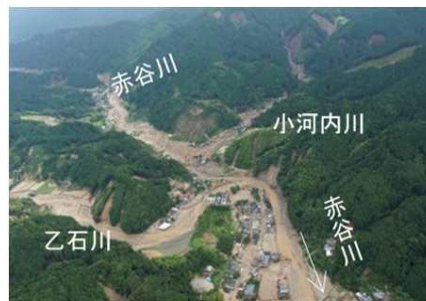
赤谷川における土砂・洪水 氾濫及び流木による被害 (福岡県朝倉市)
