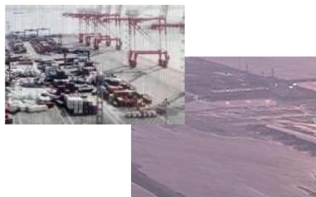
神戸港・関空における浸水被害 (神戸市、泉佐野市)
