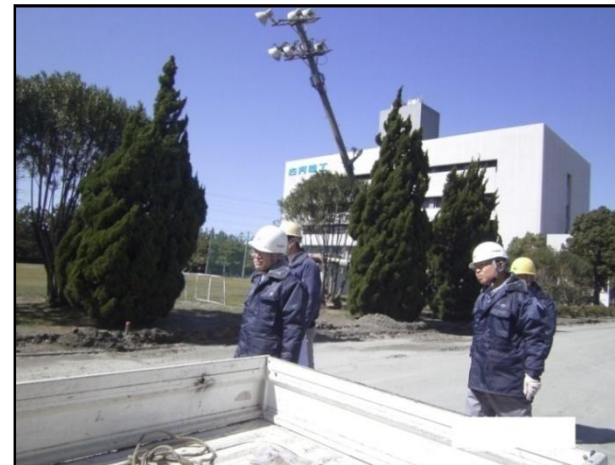
グラウンドの照明灯倒壊
