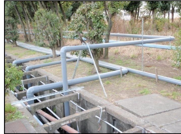
臨時配管での復旧(15日)
