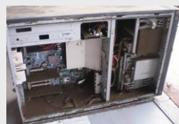
汚泥が貼りついたサーバ内部
